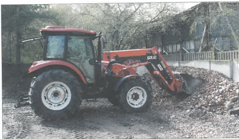
▽ Ramię ładowarkowe wraz z łyżką pozwala sprawnie załadować między innymi gruz pozostały z prac rozbiórkowych
